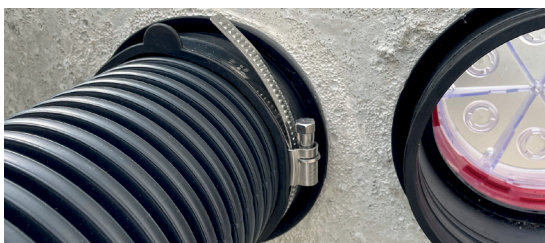
Korugovaná chránička připojená k objektu ucpávkou HSI 150 1x1 KMA 172/300
