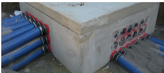
Připojená chránička Hateflex k ucpávce pomocí systémového víka HSI 150 MA 168 GR
