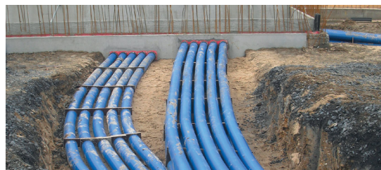
Chráničky Hateflex při propojení dvou objektů
